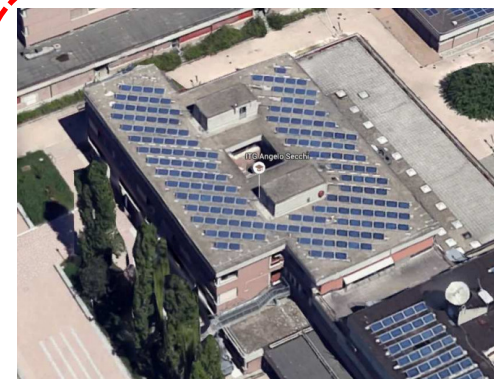
I.T.G. "A. Secchi" - Potenza Impianto 41,40 kWp
