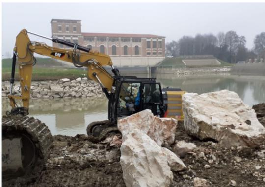
Così pure, allo sbocco in Secchia delle acque attraverso la Chiavica Emissaria si era verificata una grossa frana a causa delle piene che hanno interessato il corso d'acqua quando ancora i nuovi profili arginali (realizzati in seguito alla costruzione della nuova chiavica), non erano completamente assestati: per tali ragioni l'intervento ha visto anche la ricostruzione delle sponde allo sbocco della Chiavica stessa.
